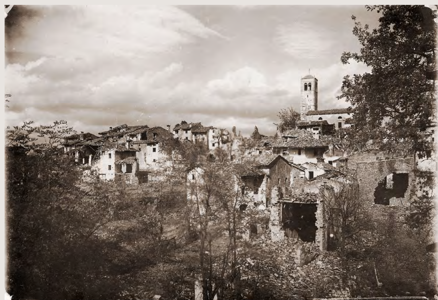
Gradišče nad Prvačino, 30. 9. 1917
