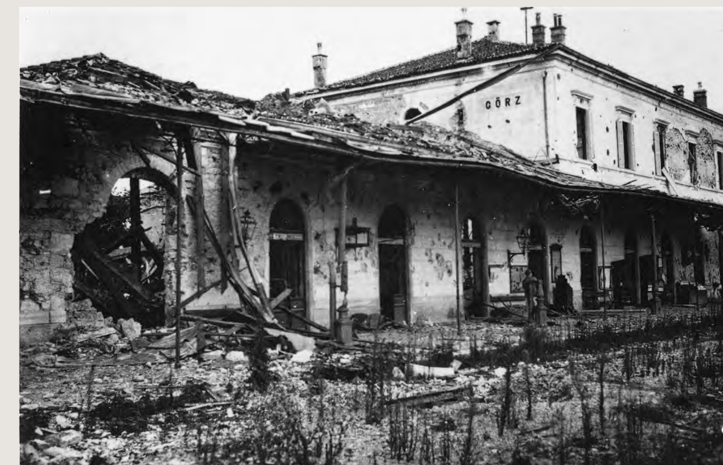
Poškodovana severna goriška železniška postaja
