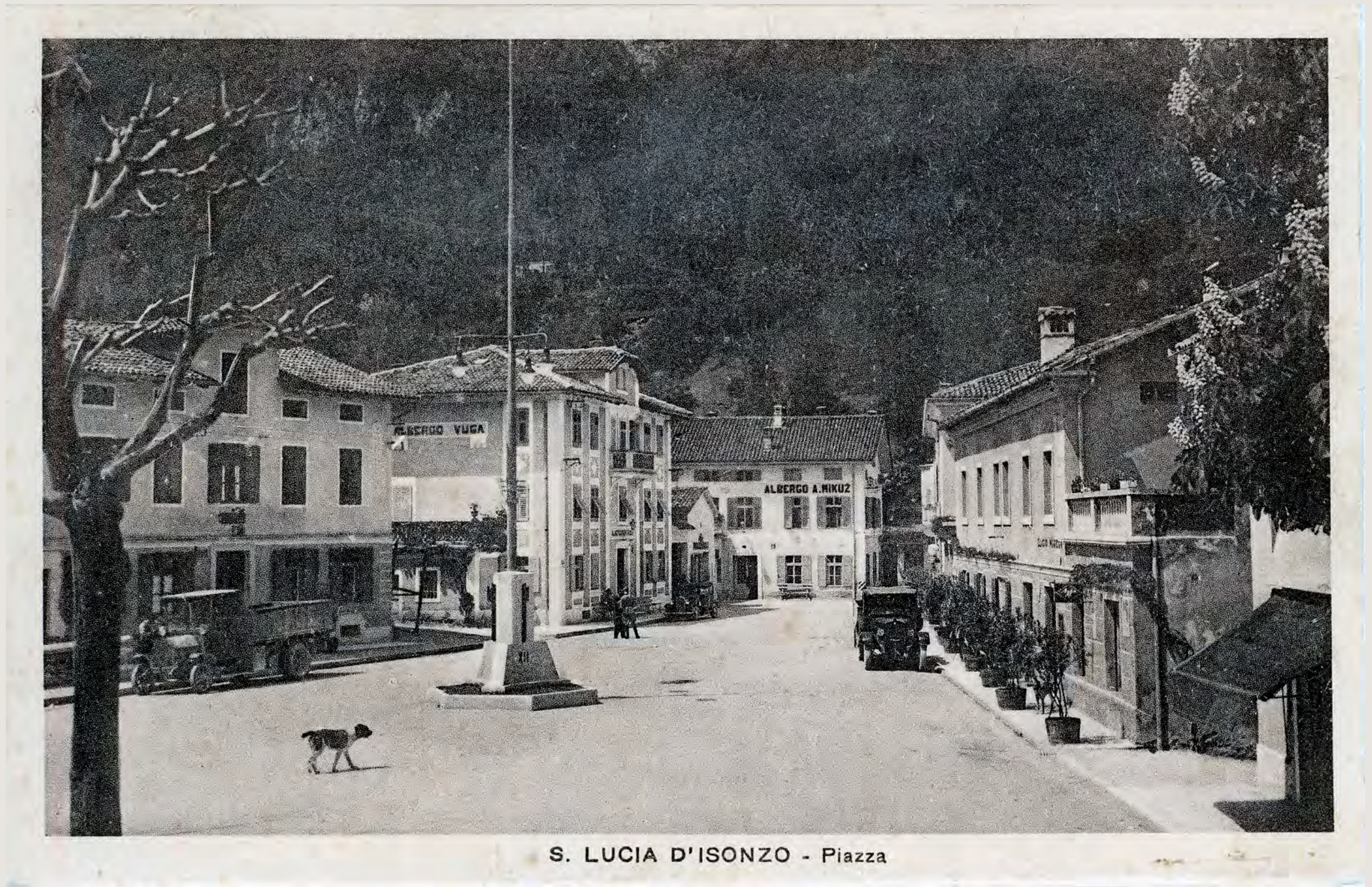
Most na Soči, glavni trg po povojni obnovi, stanje leta 1939 (Vir: PANG)
