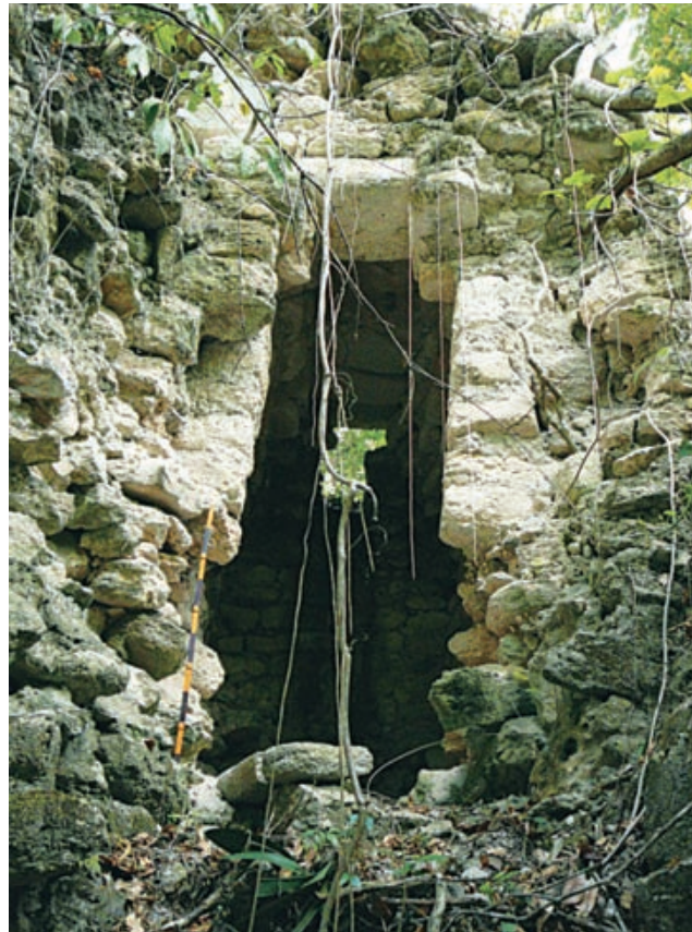
Na vrhu ene od stavb v Uitzilnáju smo naleteli na dokaj dobro ohranjen obokan prostor.
